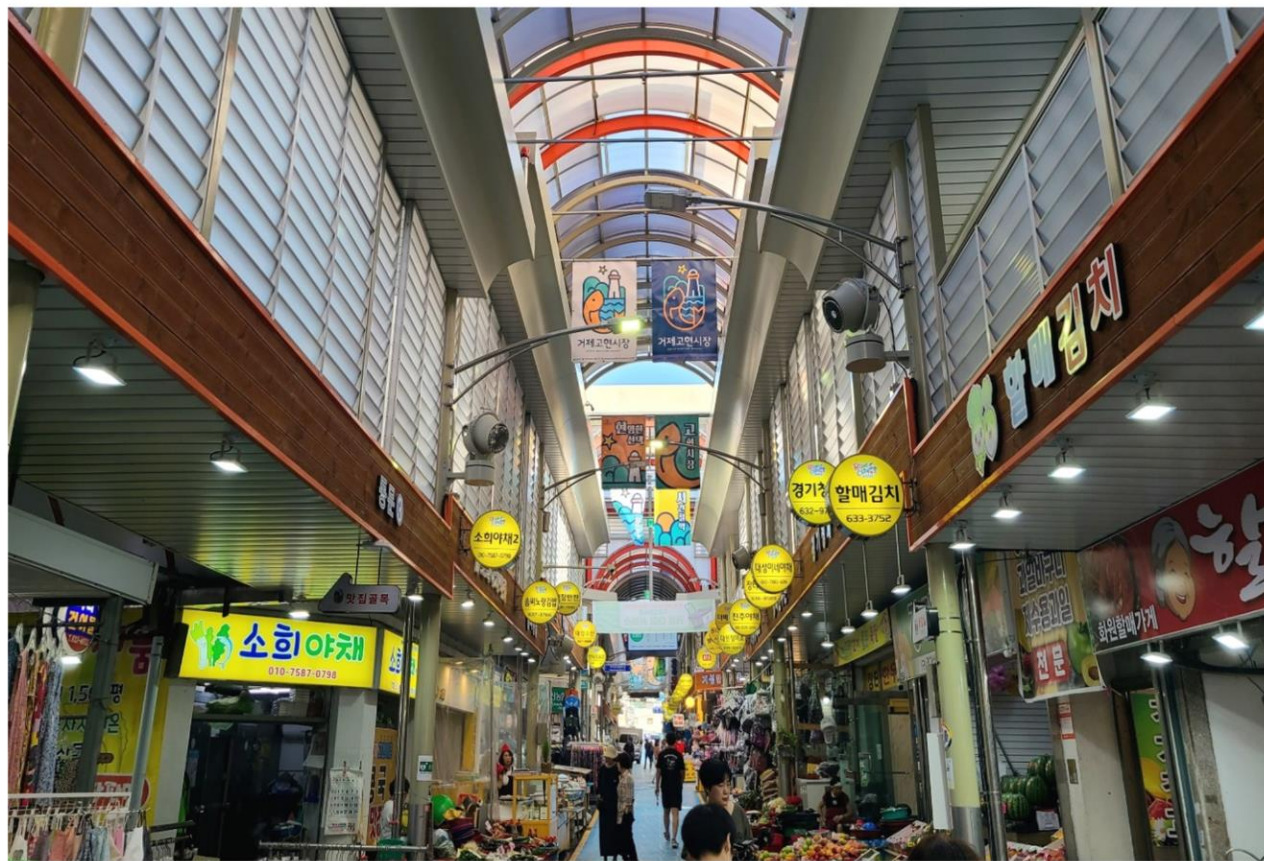
2023 거제 고현시장 미스트팬 설치
