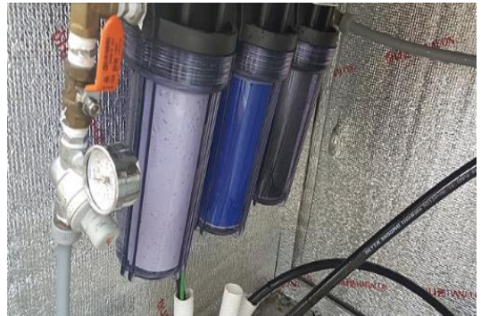
실제 설치 사진 (Preflow filter 10μm - Carbon filter - Preflow filter 1μm 순)
